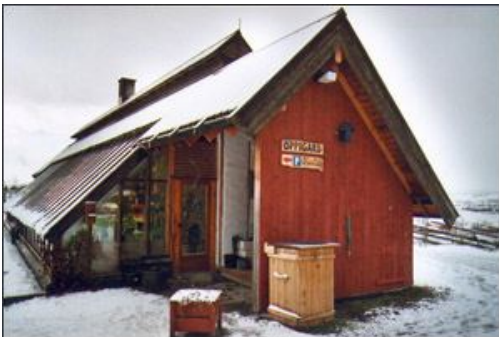
Veksthusprosjekt Havdal gård , Melhus i Trøndelag. Bygget har en rekke funksjoner; hønehus, drivhus med to temperatursoner, arbeidsrom, og rensesentral for gårdens avløpsvann. Bygget er utformet som et lavenergiveksthus med bla. bruk av godt isolerende halballvegger mot nord. Ark. Rolf Jacobsen.
