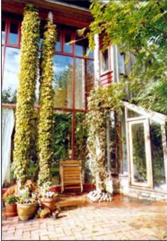
Bolig i Stavanger. Her plasseres veksthus og en stor glassfasade mot sør og tilfører rommene både lys og varme gjennom en direkte eller indirekte innstråling. Ark. Dag Roalkvam / Rolf Jacobsen
